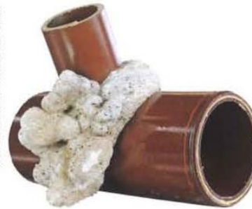
Bild 2: Erscheinungsbild einer Stützsanierung mit Injektionsverfahren
