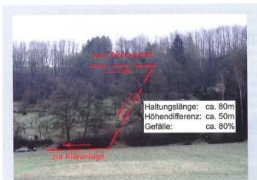
Bild 1: Kanaltrasse mit großer Höhendifferenz
